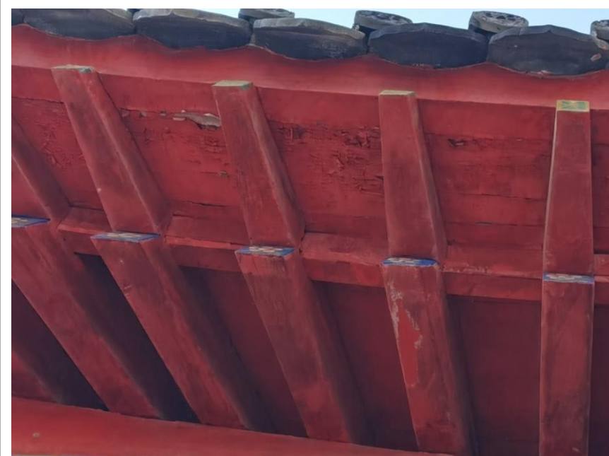
07 檐部部分木望板、飞椽有水渍污染，存在糟朽现象
