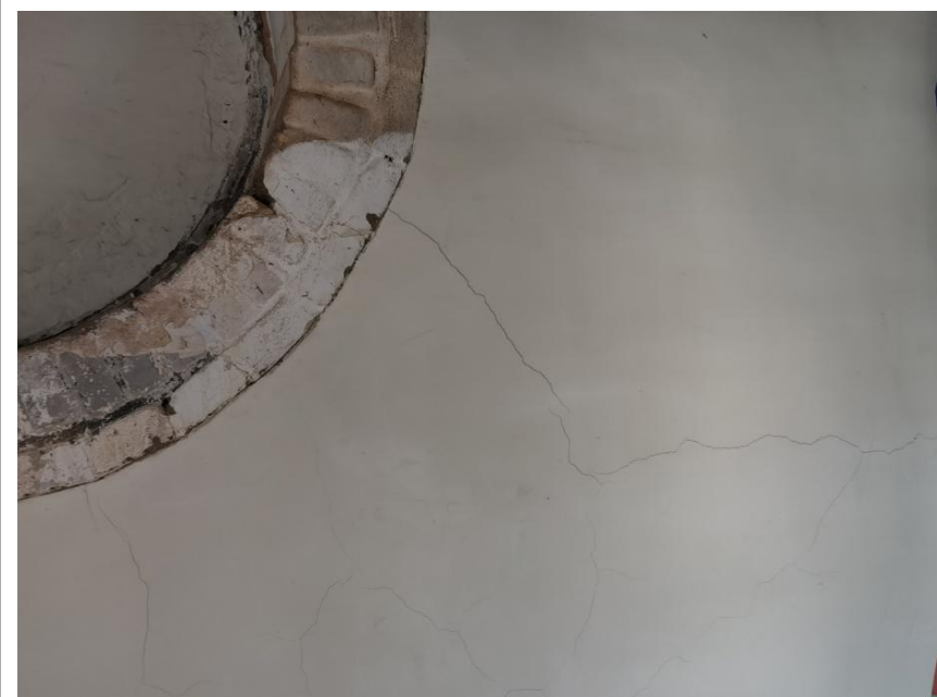
10 室内墙面白灰抹灰有多处网状裂缝，裂缝宽度 <2\text{mm}
