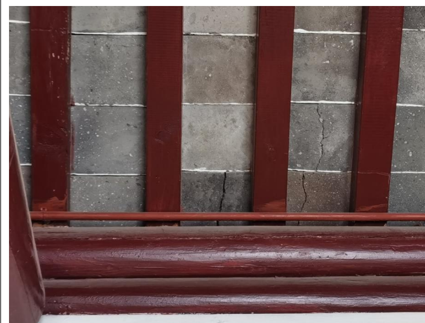
09 数块望砖有断裂残损现象
