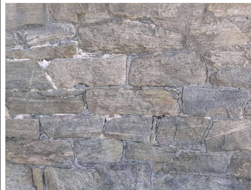
12 化妆室台基部位部分石料破碎，酥碱，勾缝灰脱落
