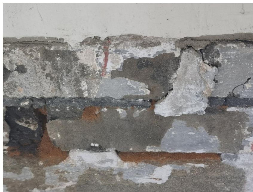
11 化妆室部分青砖破碎，酥碱，勾缝灰脱落。
