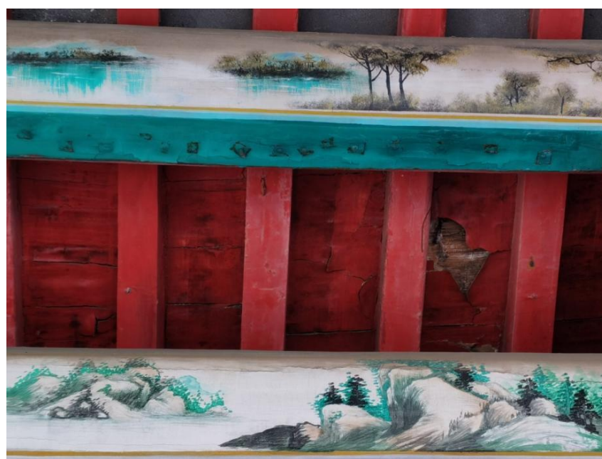
08 檐部部分木望板、飞椽有水渍污染，存在糟朽现象
